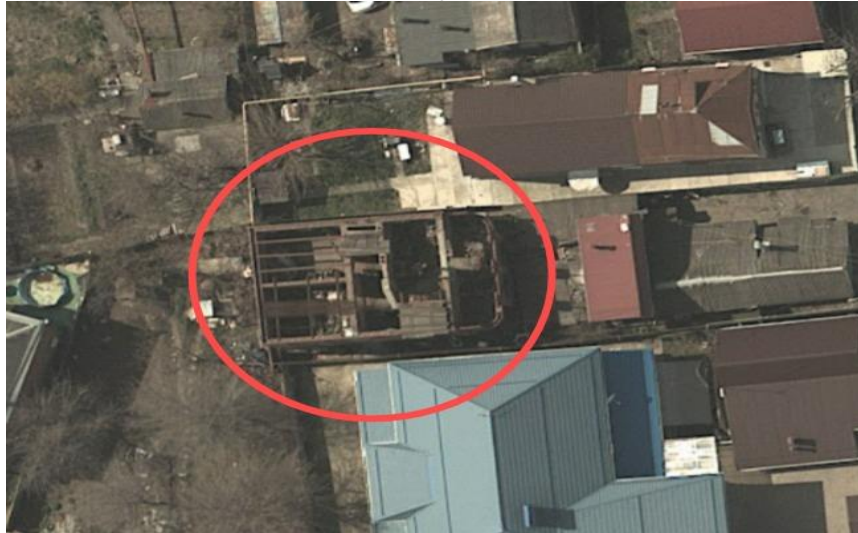
Рисунок 3. Пример полуразрушенного участка крыши
