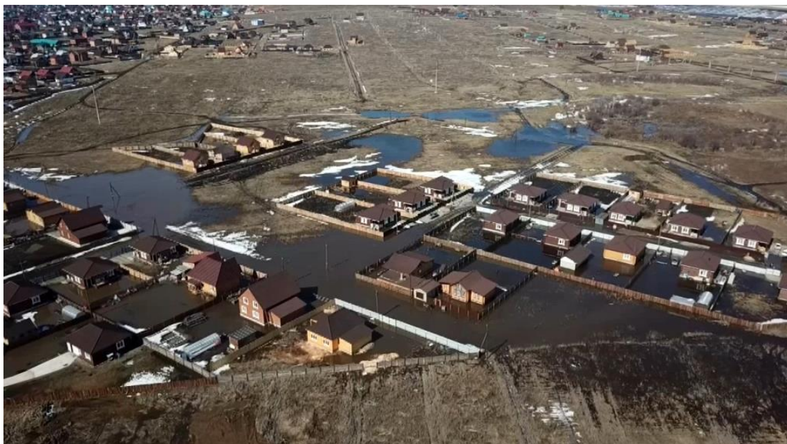
Рис.15 Подтапливаемая зона застройки Западного микрорайона Хомутово на поле, где ранее выращивали капусту (фото Яндекс, 2017г; в текущем году затопленной оказалась значительно большая по площади и количеству участков территория)
