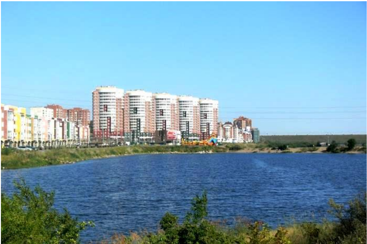
Рис.12. Высокоплотная застройка уреза прибрежной части русла Ангары под плотиной
