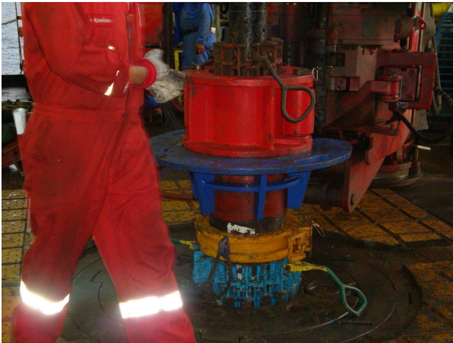
Рис. 11. Извлечение КНБК через ОК с использованием бурового инструмента 127мм.
