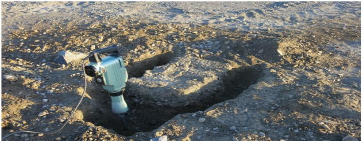
Рисунок 2 – Подготовленная к испытанию породная призма
