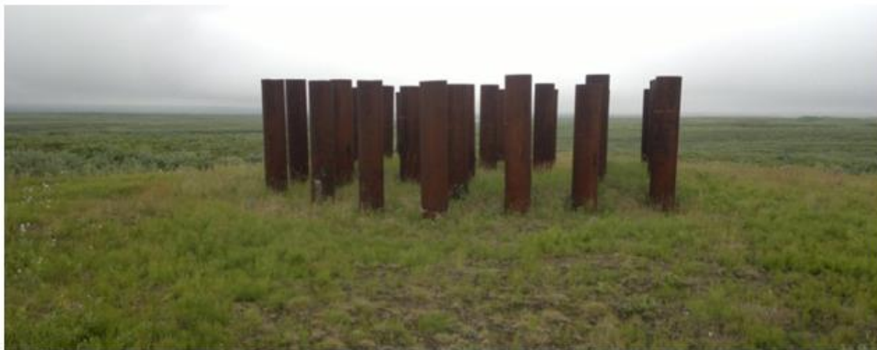
Рисунок 2. Металлические конструкции на площадке ремонта скважин
